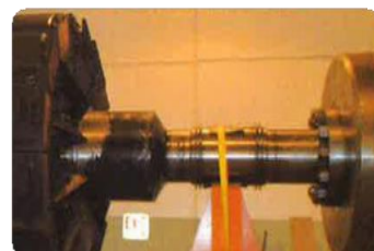
発電機の修理
