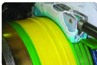
風力発電設備の修理
