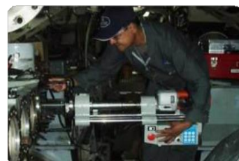
銅めっきによる補修
